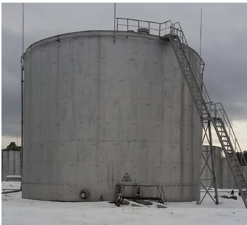
Рисунок 2 - Общий вид резервуара стального вертикального цилиндрического РВС-2000
