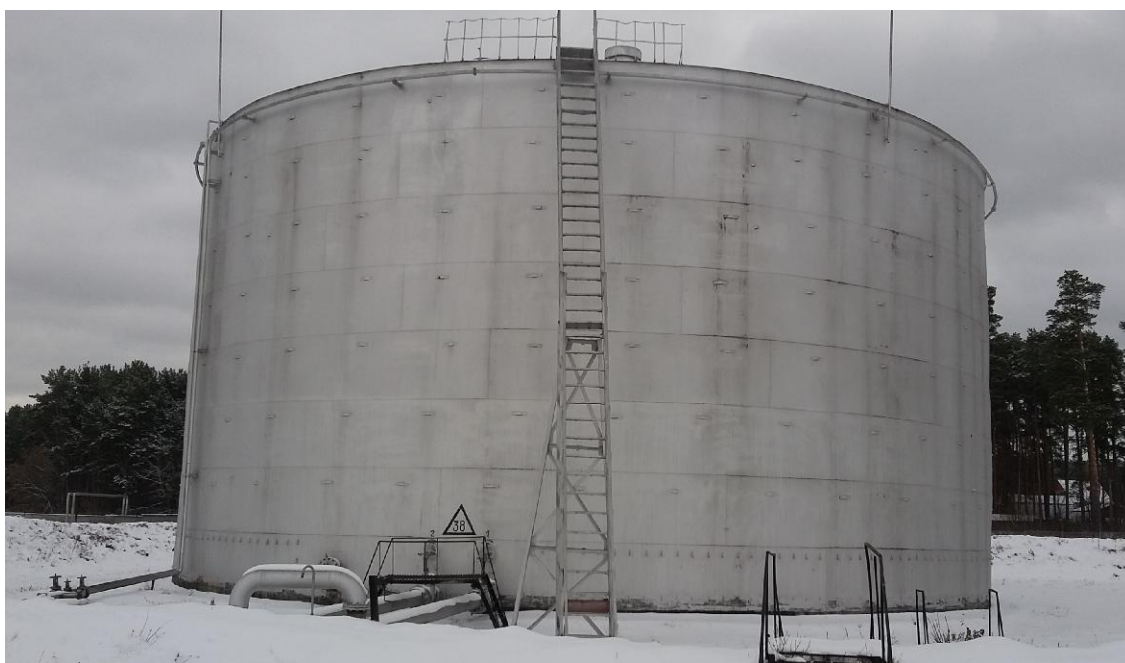
Рисунок 3 - Общий вид резервуара стального вертикального цилиндрического РВС-4800
