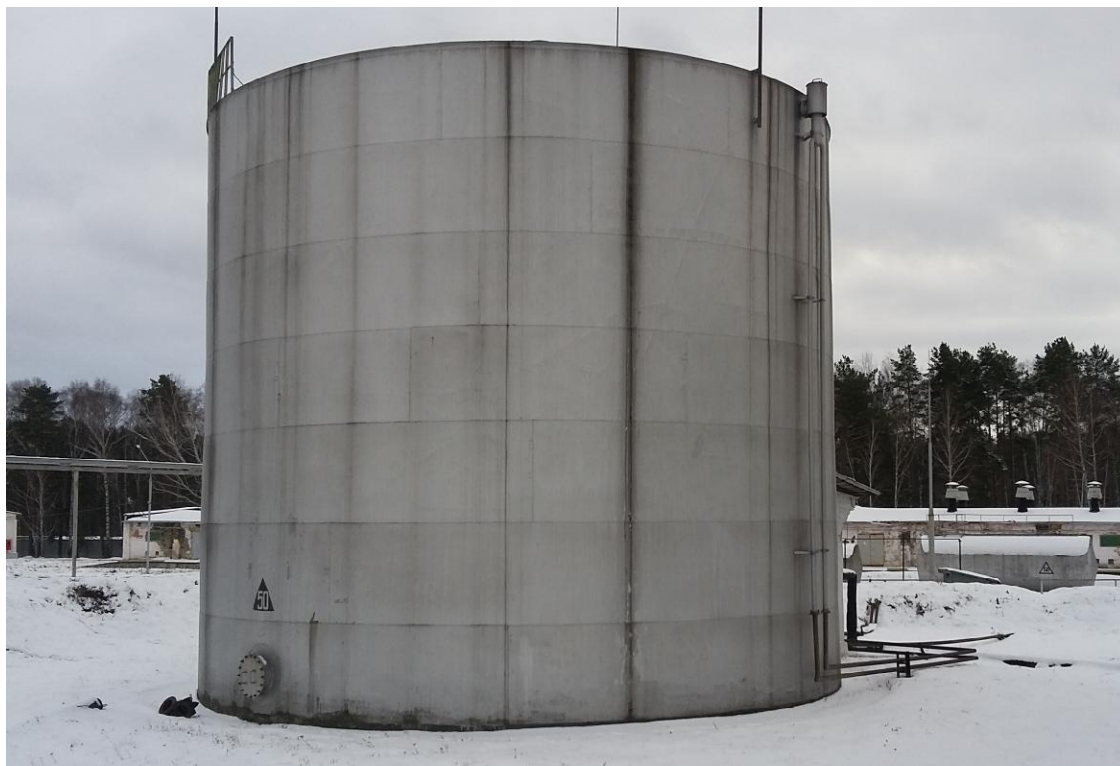
Рисунок 1 - Общий вид резервуара стального вертикального цилиндрического РВС-1000
