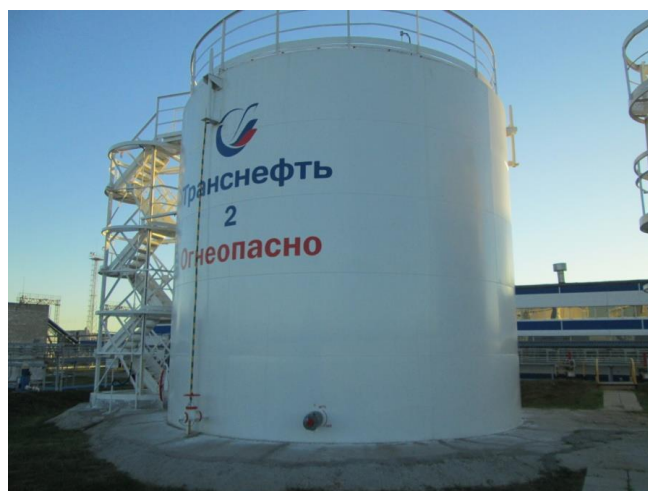
Рисунок 2 – Общий вид резервуара РВС-400 зав.№ 2
