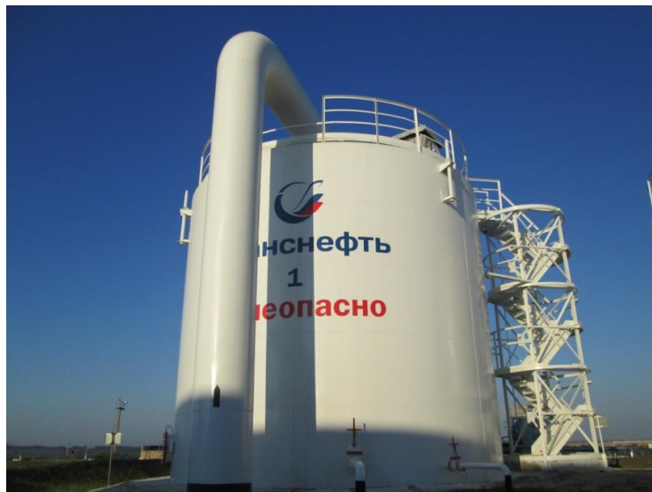
Рисунок 1 – Общий вид резервуара РВС-400 зав.№ 1
