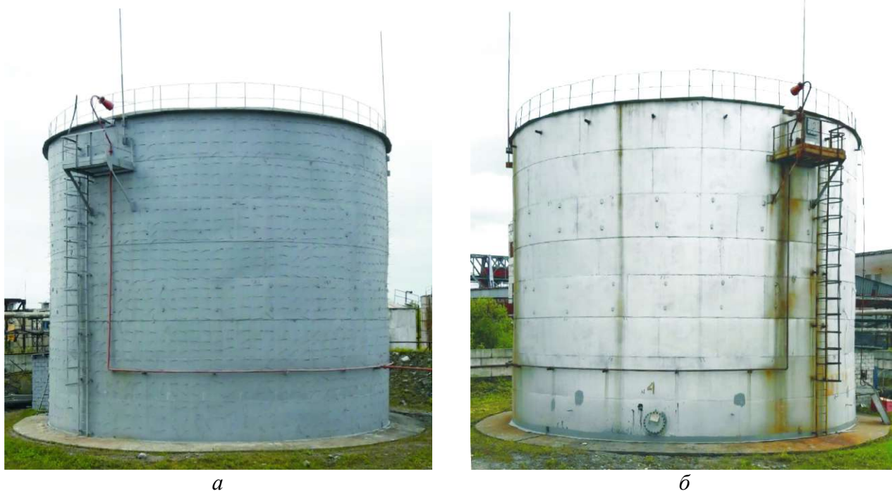
Рисунок 1 - Общий вид резервуаров РВС-2000 а - РВС-2000 №3, б - РВС-2000 №4
