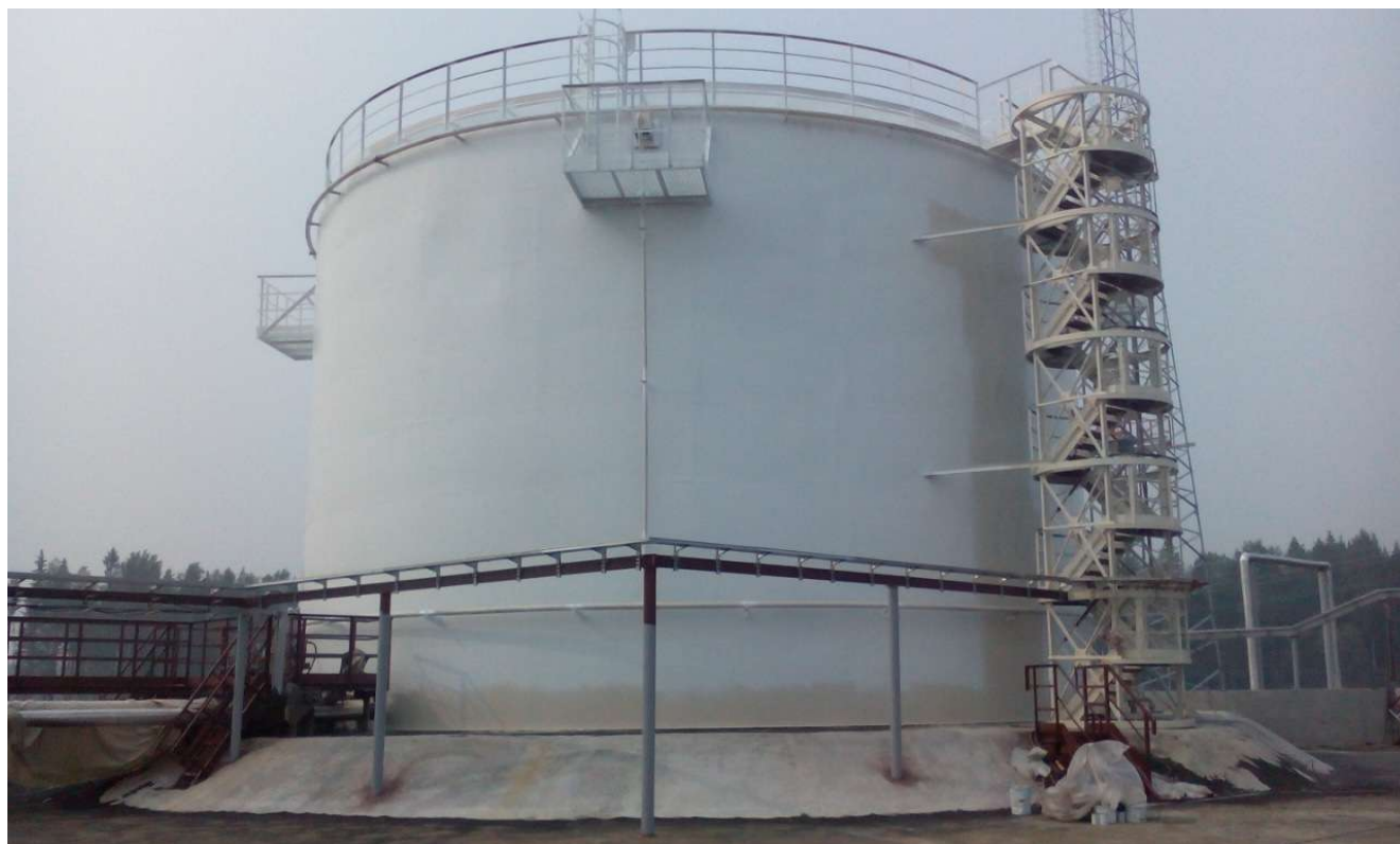
Рисунок 2 - Общий вид РВС-3000 заводской номер Р-2
