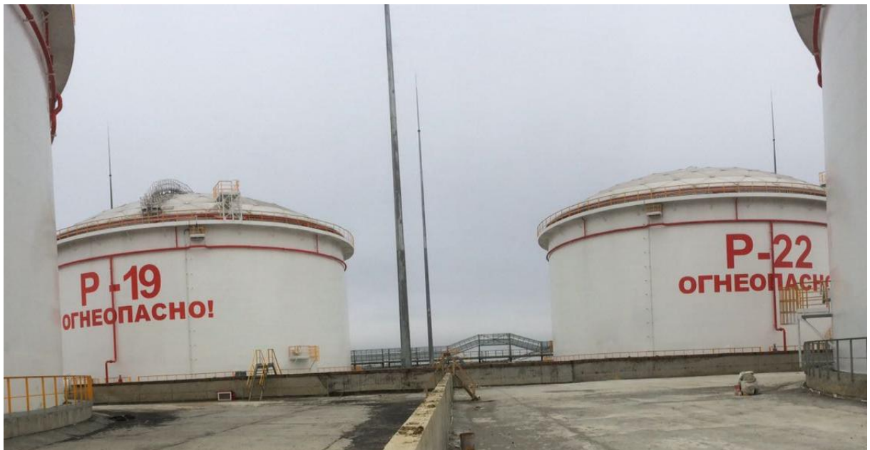
Рисунок 1 - Общий вид резервуаров
