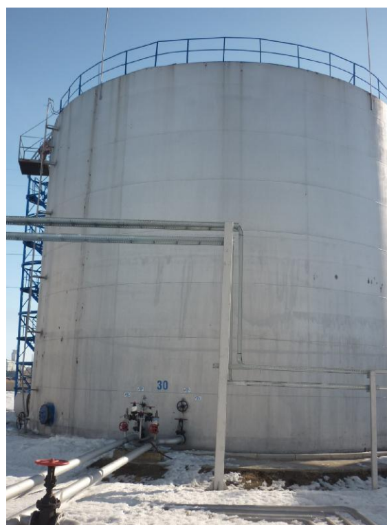
Рисунок 3 - Общий вид резервуара вертикального стального цилиндрического РВС-2000
