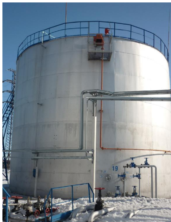
Рисунок 2 - Общий вид резервуара вертикального стального цилиндрического РВС-1000
