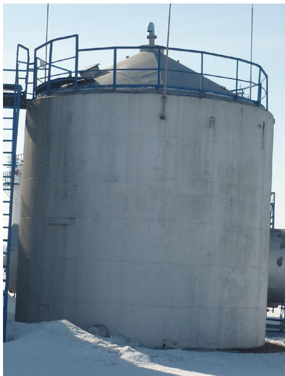
Рисунок 1 - Общий вид резервуара вертикального стального цилиндрического РВС-200
