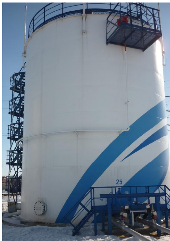
Рисунок 4 - Общий вид резервуара вертикального стального цилиндрического РВСП-1000
