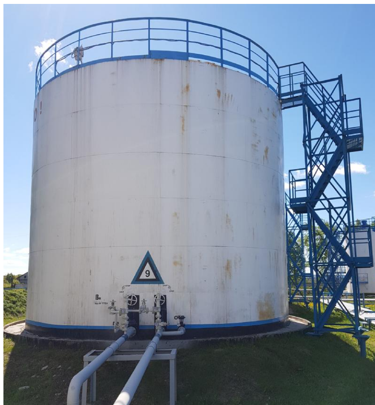
Рисунок 1 – Общий вид резервуаров вертикальных стальных цилиндрических РВС-700, РВСП-700
