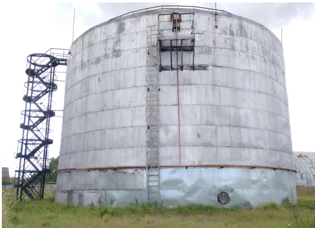
Рисунок 2 - Общий вид резервуара вертикального стального цилиндрического РВС-3000
