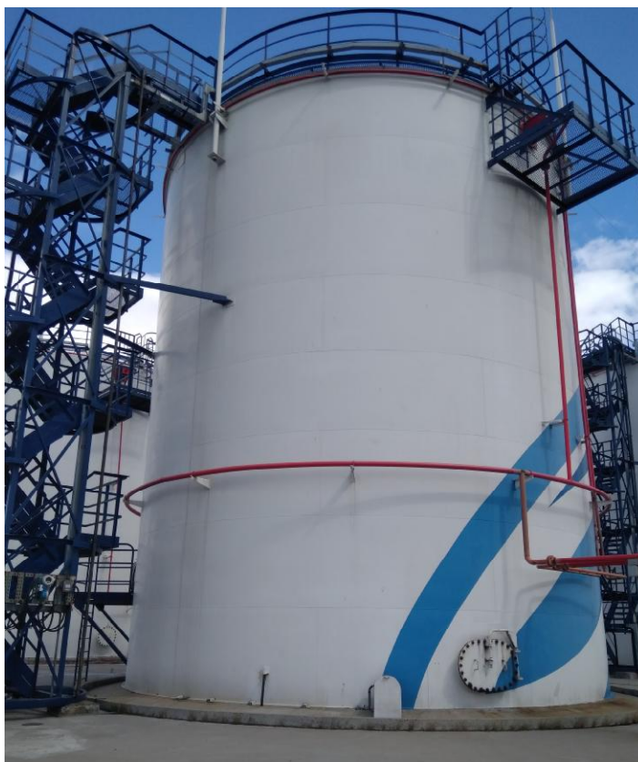
Рисунок 1 - Общий вид резервуара вертикального стального цилиндрического РВС-1000
