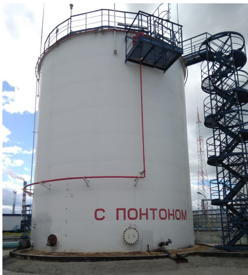
Рисунок 3 - Общий вид резервуара вертикального стального цилиндрического РВСП-1000
