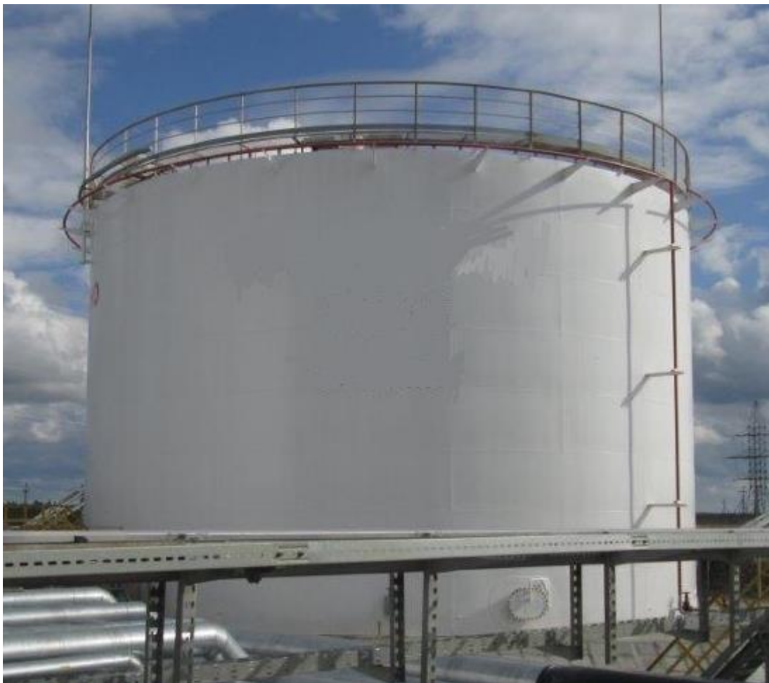
Рисунок 1 - Общий вид резервуара стального вертикального цилиндрического РВС-3000
