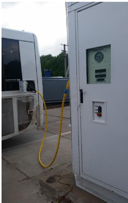
Рисунок 3 - Общий вид системы отпуски БРС-МКПП
