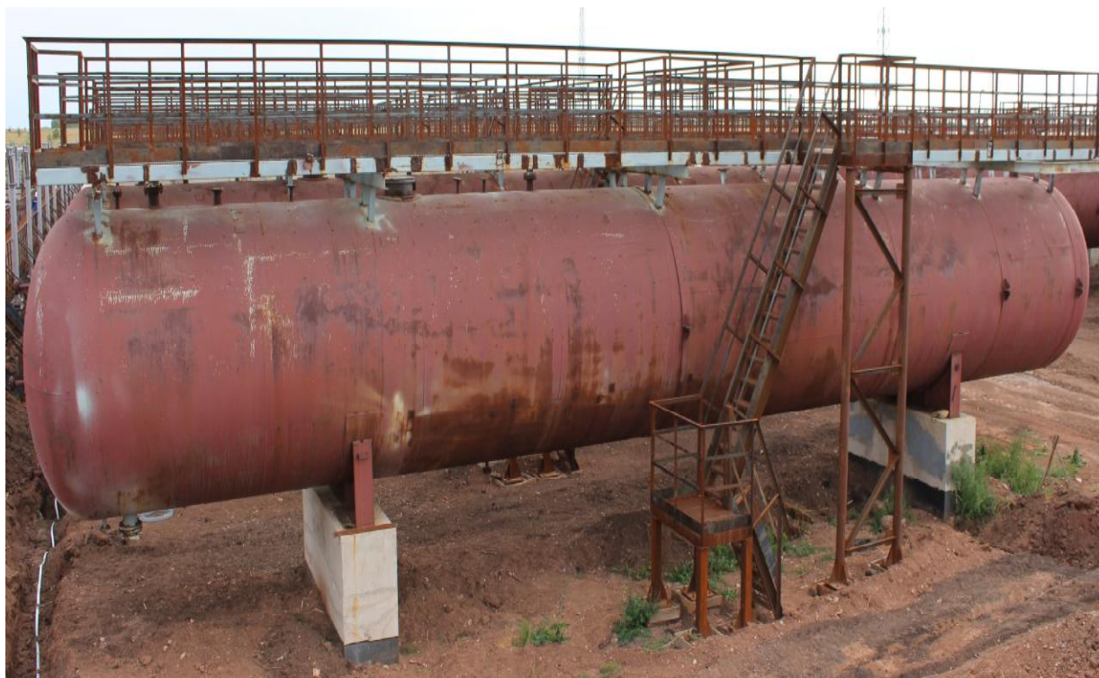
Рисунок 1 – Общий вид резервуара стального горизонтального цилиндрического ПС-200
