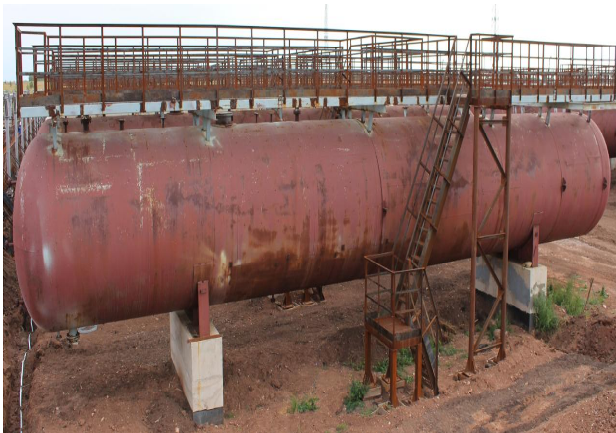
Рисунок 1 – Общий вид резервуара стального горизонтального цилиндрического ПС-200
