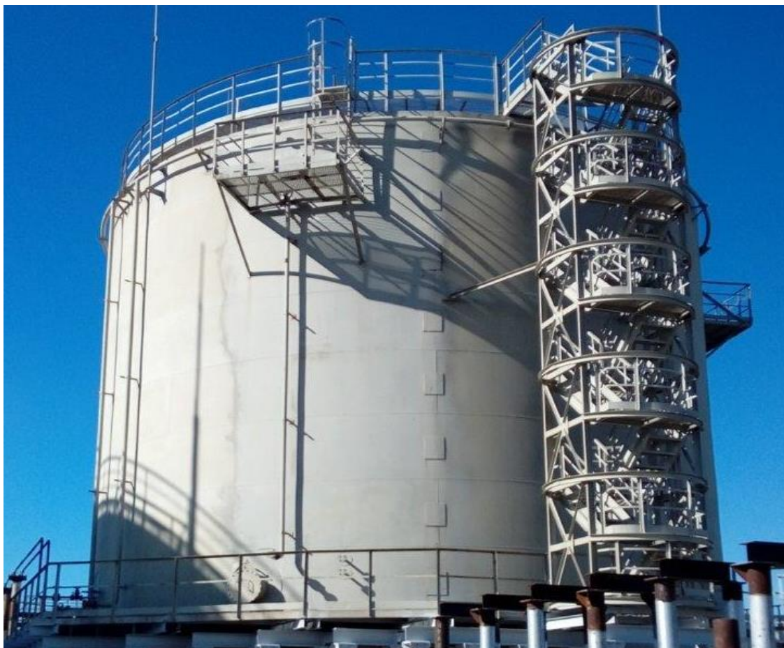
Рисунок 1 - Общий вид резервуара стального вертикального цилиндрического РВС-2000
