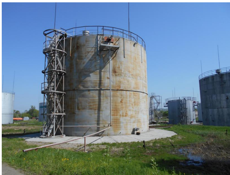
Рисунок - 2 Общий вид резервуара РВС-700 № 29
