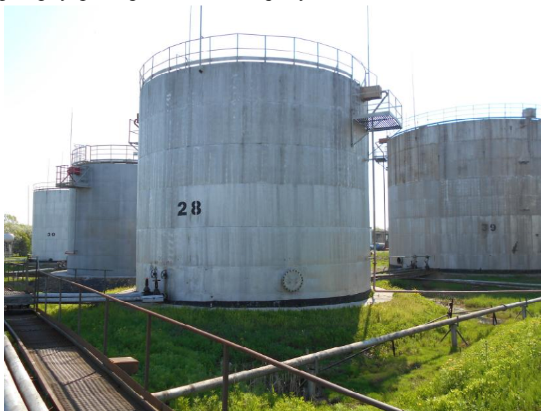
Рисунок - 1 Общий вид резервуара РВС-700 № 28
