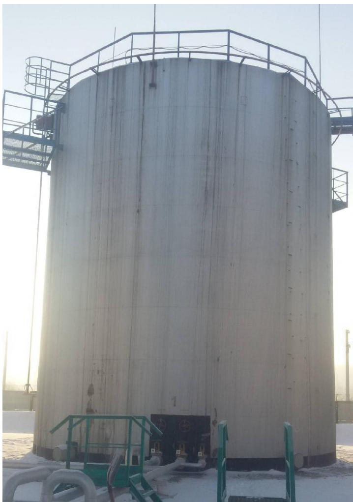
Рисунок 1 - Общий вид резервуара вертикального стального цилиндрического РВС-1000
