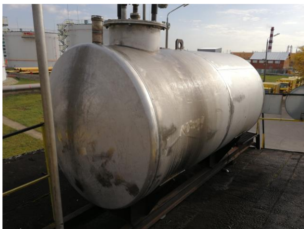
Рисунок 1 – Общий вид резервуаров РГС-5 зав.№№ 7, 8
