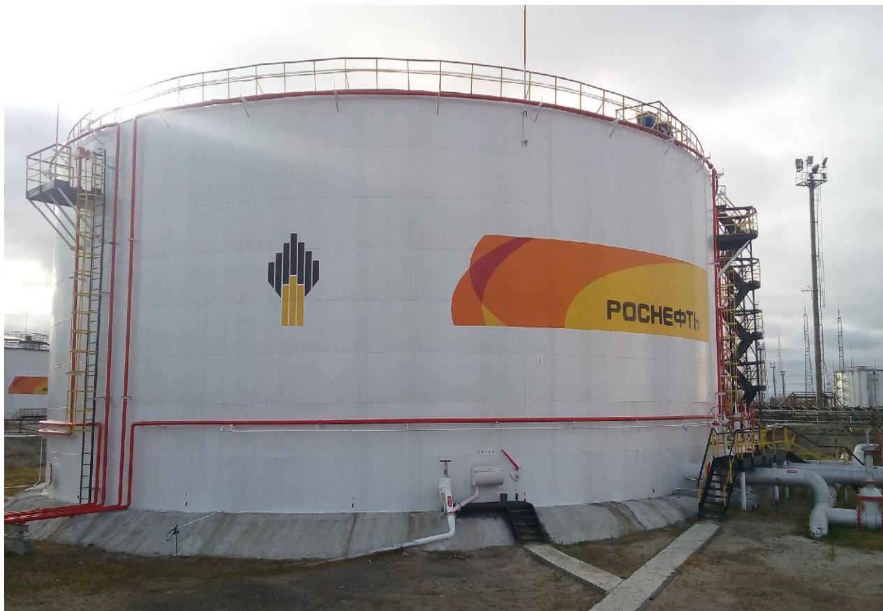
Рисунок 1 - Общий вид резервуара стального вертикального цилиндрического РВС-10000
