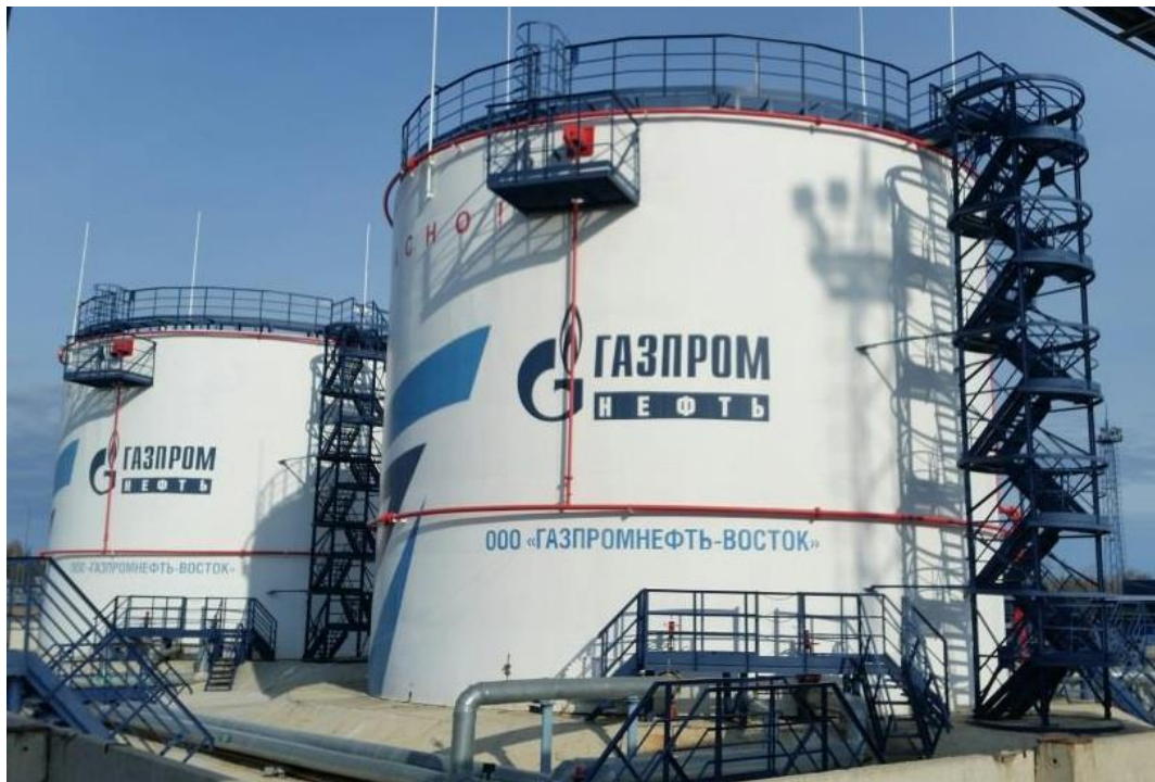
Рисунок 1 - Общий вид резервуара РВС-2000 заводские номера 1, 2
