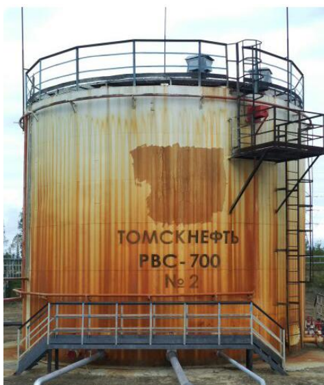
Рисунок 1 - Общий вид резервуара
