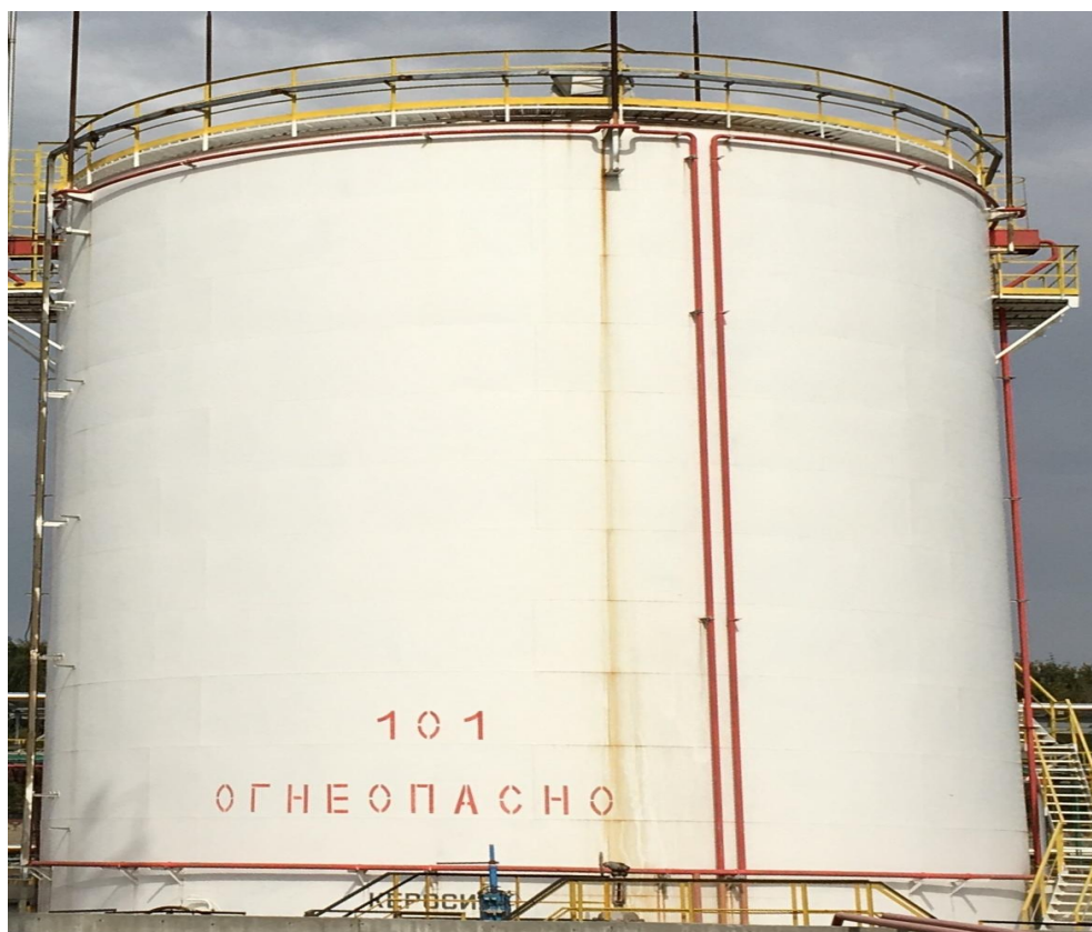
Рисунок 1 - Общий вид резервуара стального вертикального цилиндрического РВС-3000
