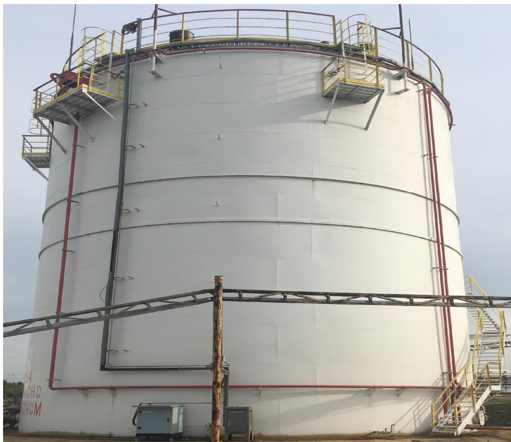
Рисунок 2 - Общий вид резервуара стального вертикального цилиндрического РВСП-3000
