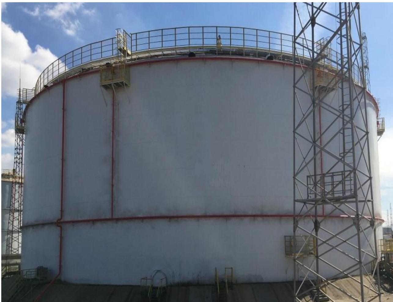
Рисунок 1 - Общий вид резервуара стального вертикального цилиндрического РВСП-50000
