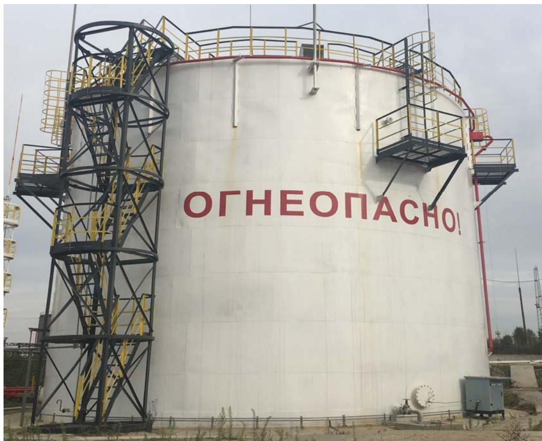
Рисунок 2 - Общий вид резервуара стального вертикального цилиндрического РВСП-2000
