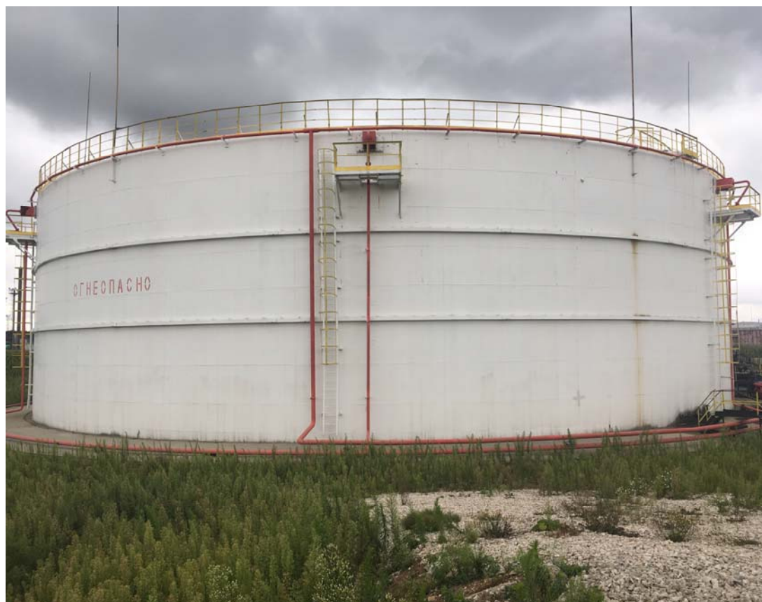
Рисунок 3 - Общий вид резервуара стального вертикального цилиндрического РВС-20000, РВСП-20000
