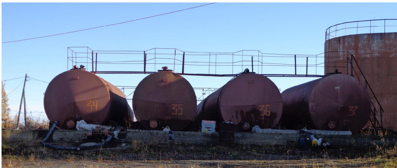
Рисунок 1 - Общий вид резервуаров РГС-50, РГС-60
