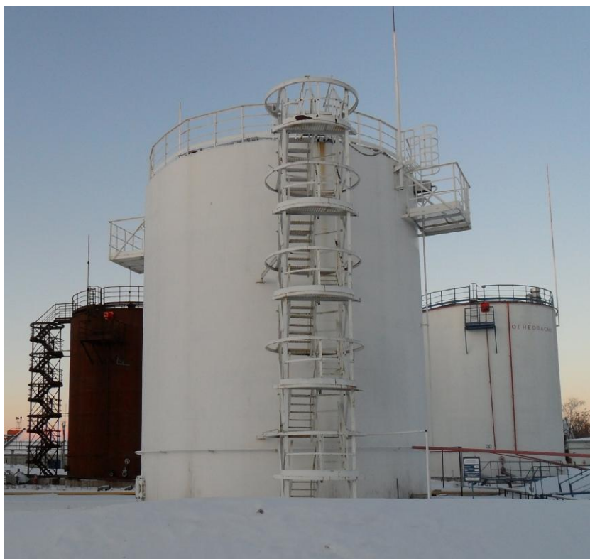
Рисунок 2 - Общий вид резервуара вертикального стального цилиндрического PVC-1000
