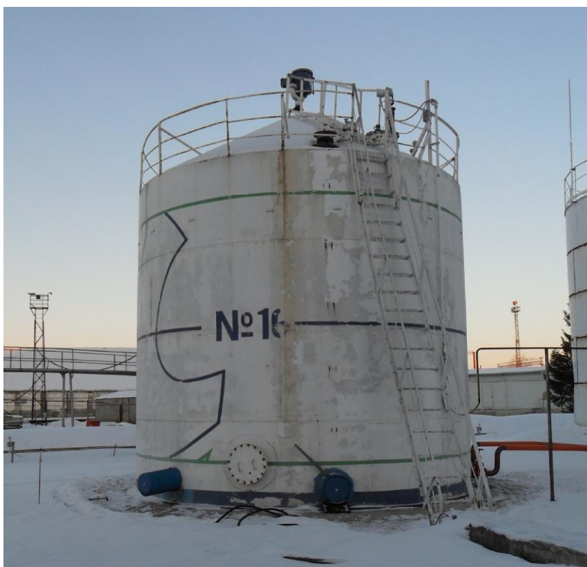
Рисунок 1 - Общий вид резервуара вертикального стального цилиндрического РВС-200
