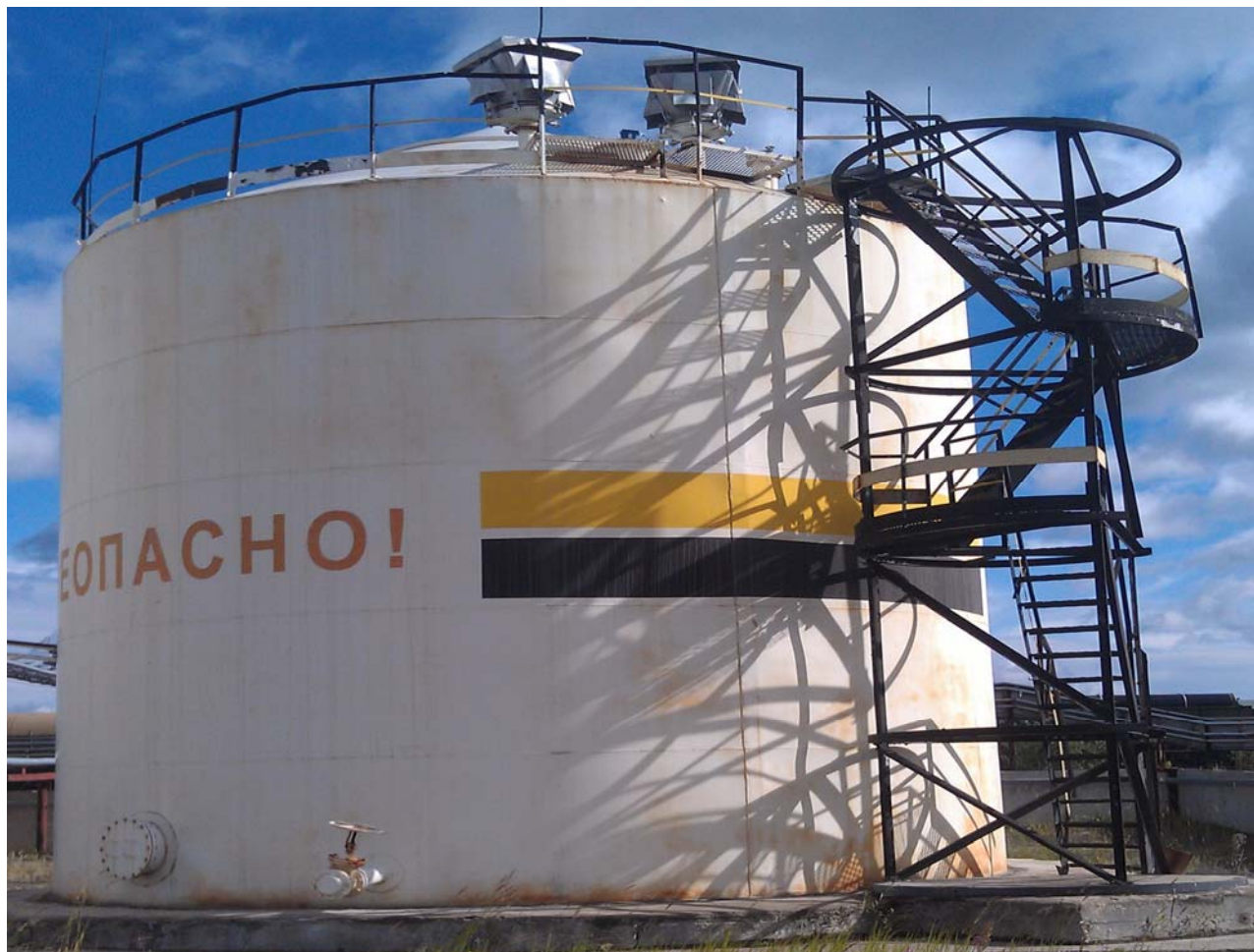
Рисунок 1 - Общий вид резервуара стального вертикального цилиндрического РВС-400
