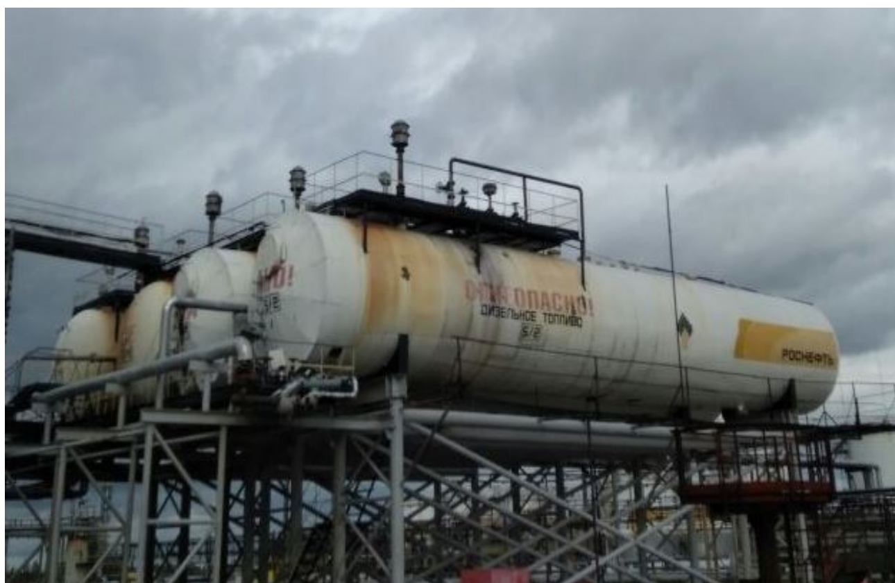
Рисунок 1 - Общий вид резервуара стального горизонтального цилиндрического РГС-200
