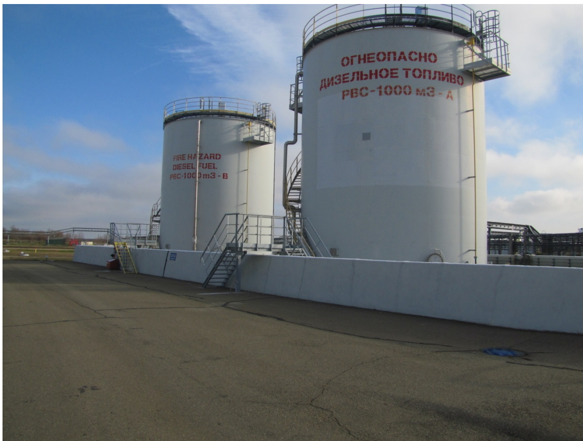
Рисунок 1 - Общий вид резервуаров РВС-1000
