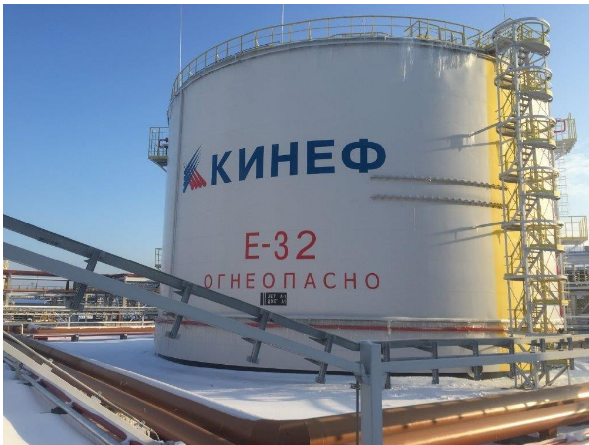
Рисунок 1 - Общий вид резервуара РВС-10000
