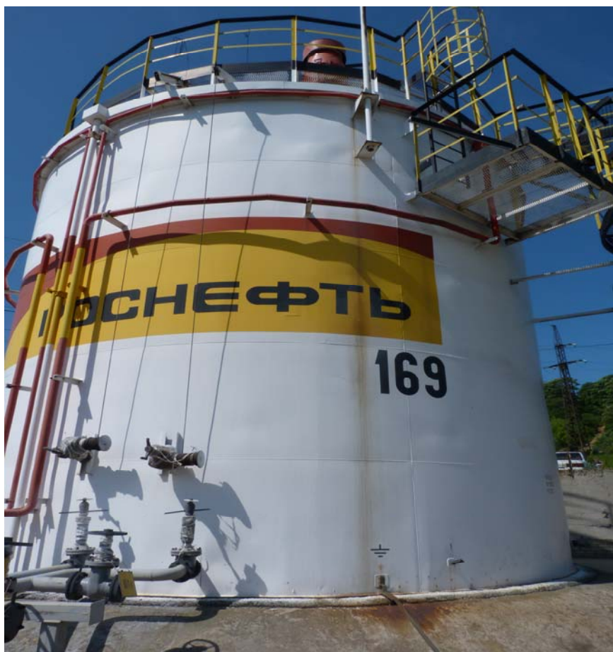
Рисунок 1 - Общий вид резервуара вертикального стального цилиндрического РВС-400
