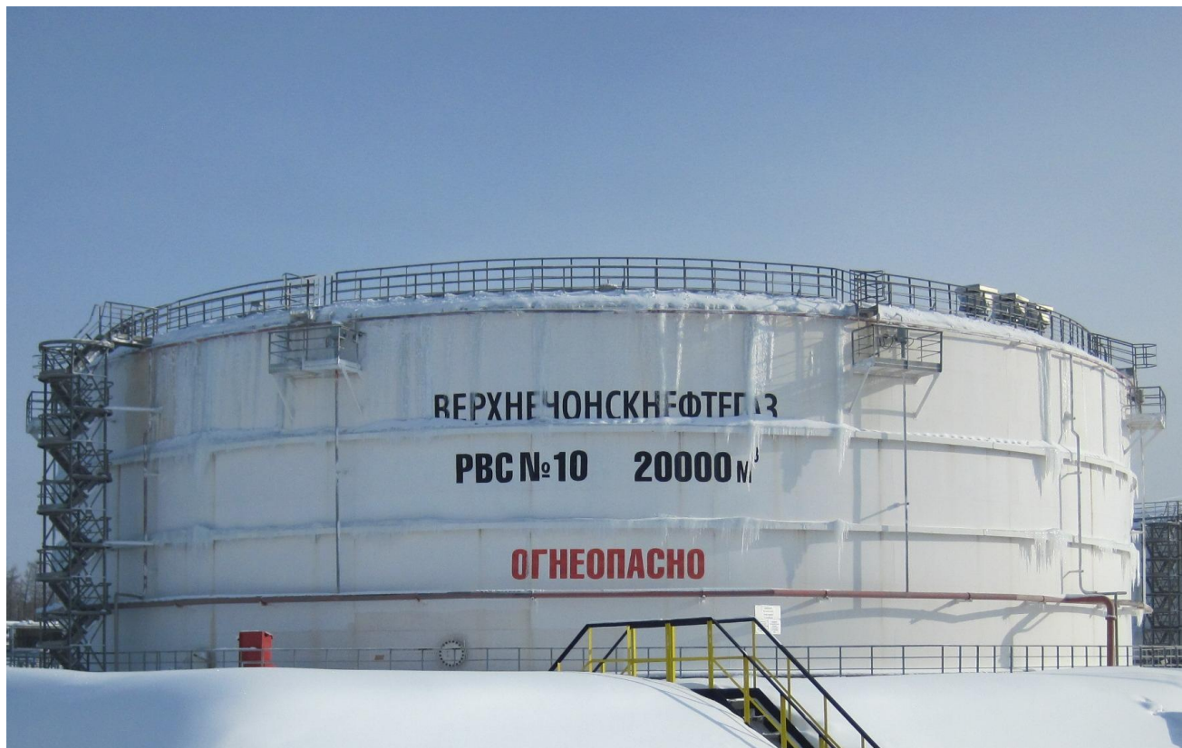
Рисунок 1 - Общий вид резервуара стального вертикального цилиндрического РВС-20000
