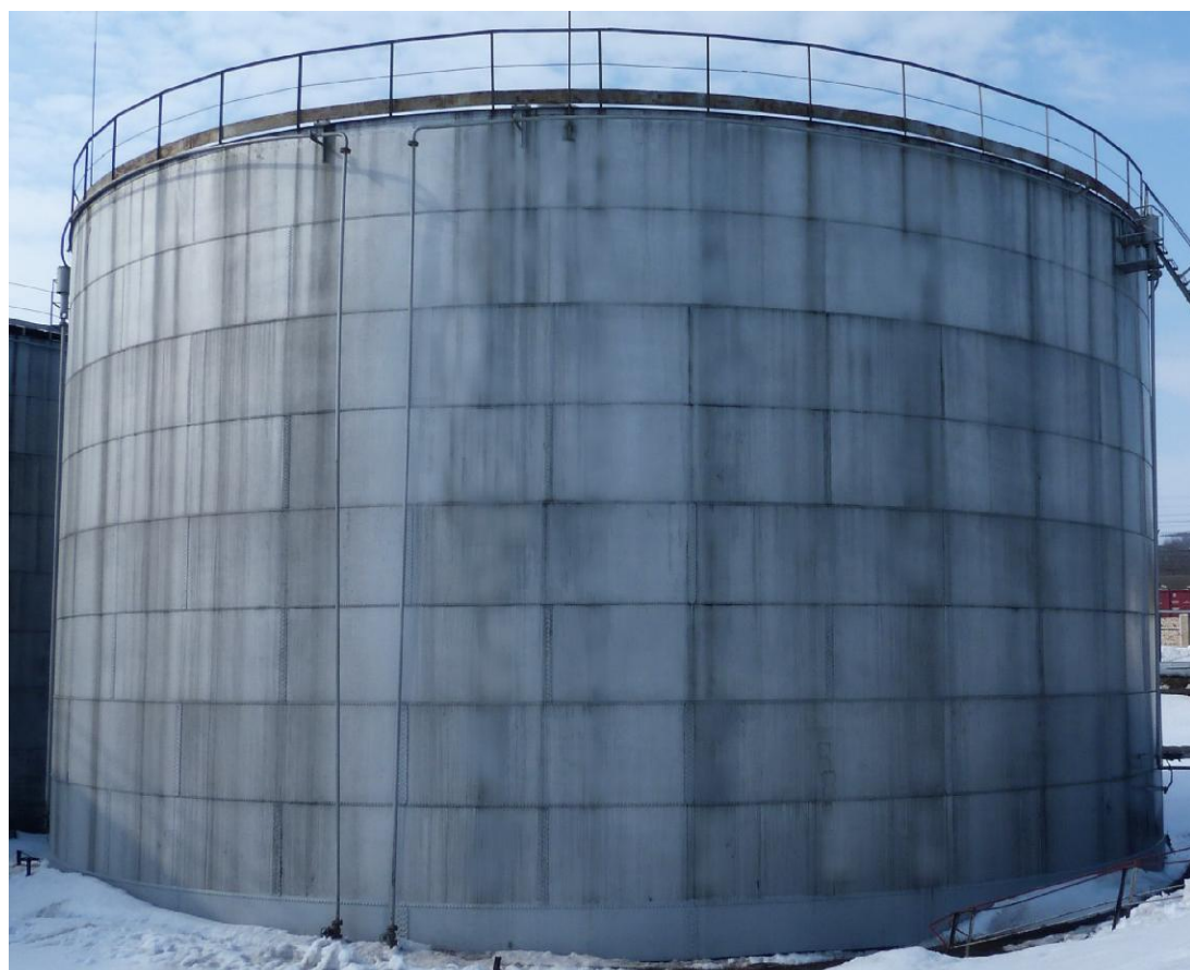
Рисунок 3 – Общий вид резервуара стального вертикального цилиндрического РВС-5000
