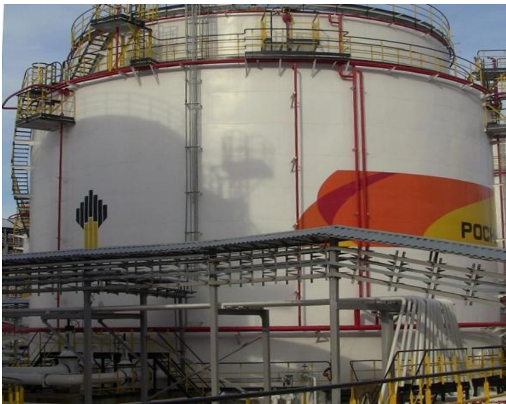
Рисунок 1 - Общий вид резервуаров с защитной стенкой РВС-5000, РВСП-5000
