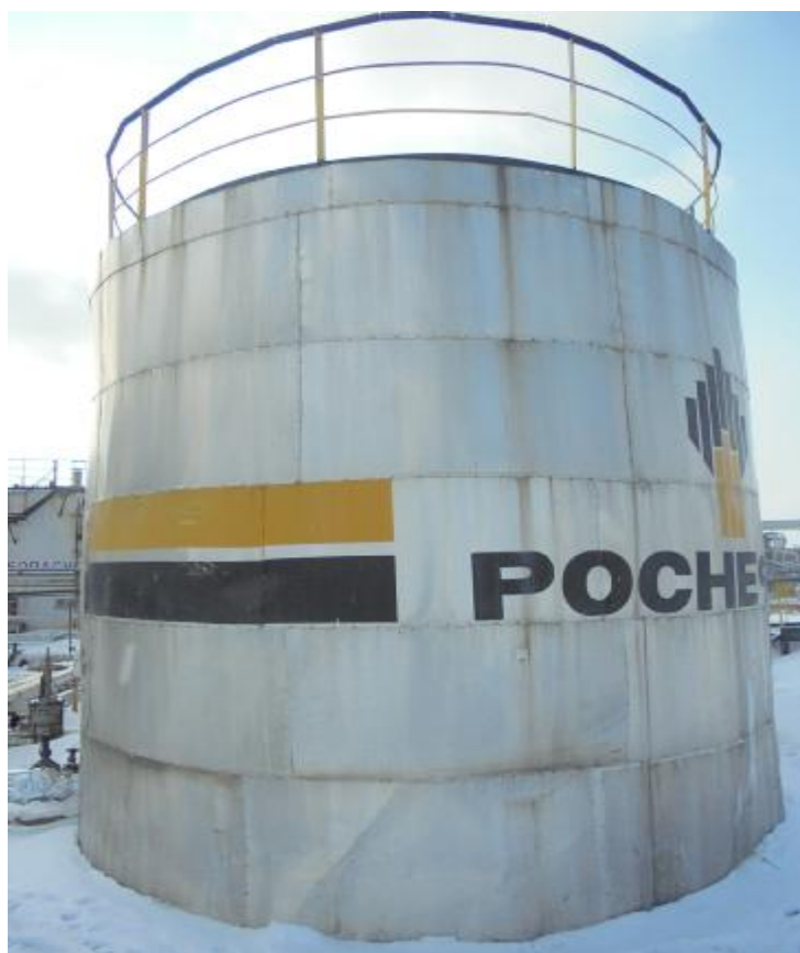
Рисунок 1 – Общий вид резервуара стального вертикального цилиндрического РВС-200
