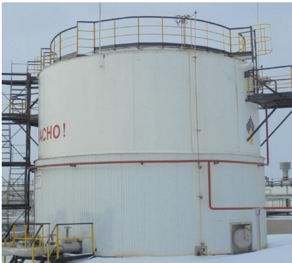
Рисунок 4 – Общий вид резервуара стального вертикального цилиндрического РВС-700
