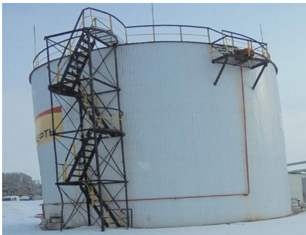
Рисунок 5 – Общий вид резервуара стального вертикального цилиндрического РВС-1000
