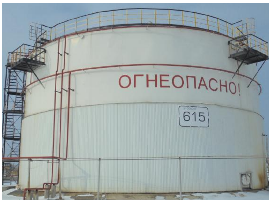
Рисунок 6 – Общий вид резервуара стального вертикального цилиндрического РВС-5000
