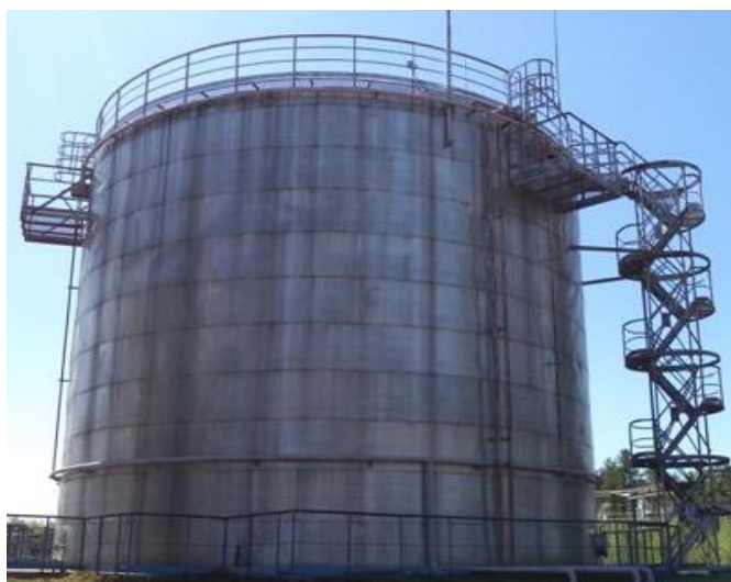
Рисунок 1 – Общий вид резервуара
