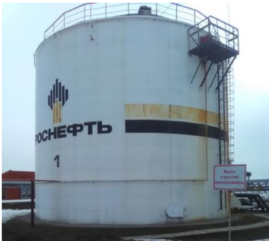
Рисунок 1 - Общий вид резервуара стального вертикального цилиндрического РВС-2000
