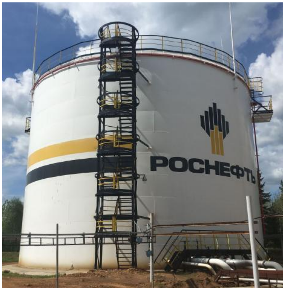
Рисунок 2 - Общий вид резервуара стального вертикального цилиндрического РВС-5000
