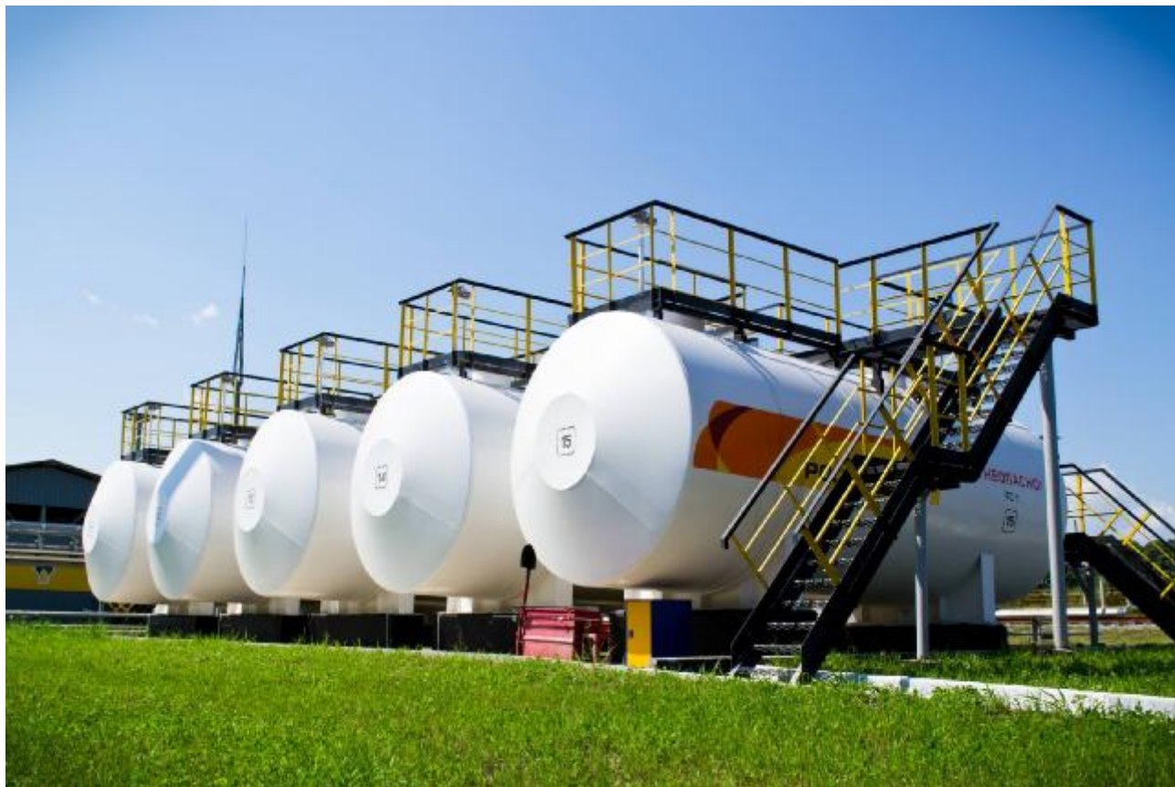
Рисунок 1 - Общий вид резервуара стального горизонтального цилиндрического РГС-75
