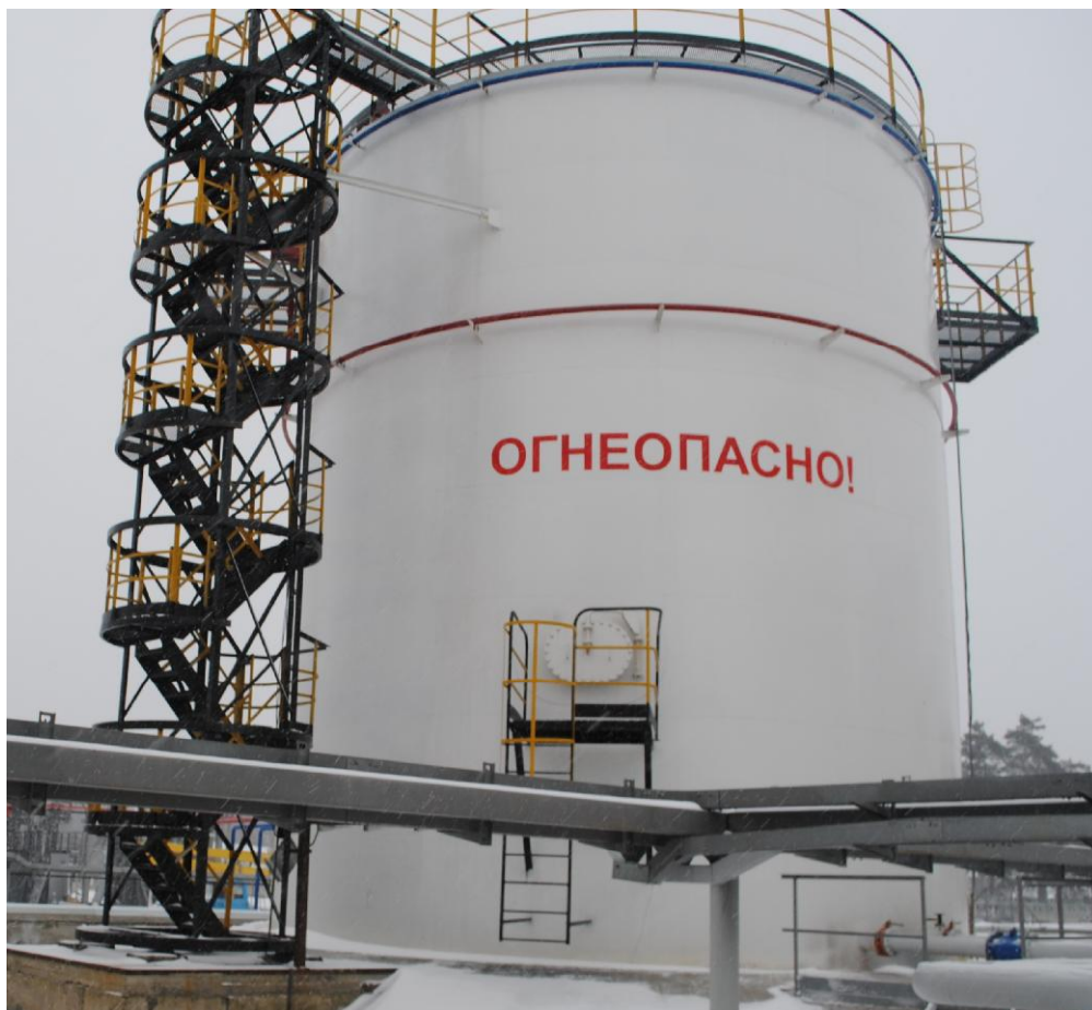
Рисунок 1 - Общий вид резервуара стального вертикального цилиндрического РВС-1000, РВСП-1000
