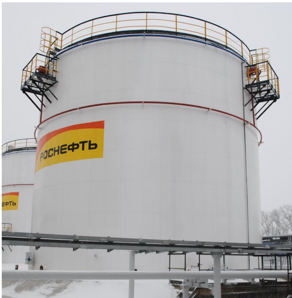
Рисунок 2 - Общий вид резервуара стального вертикального цилиндрического РВС-2000, РВСП-2000
