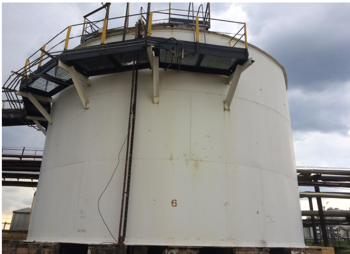
Рисунок 1 - Общий вид резервуара стального вертикального цилиндрического РВС-400
