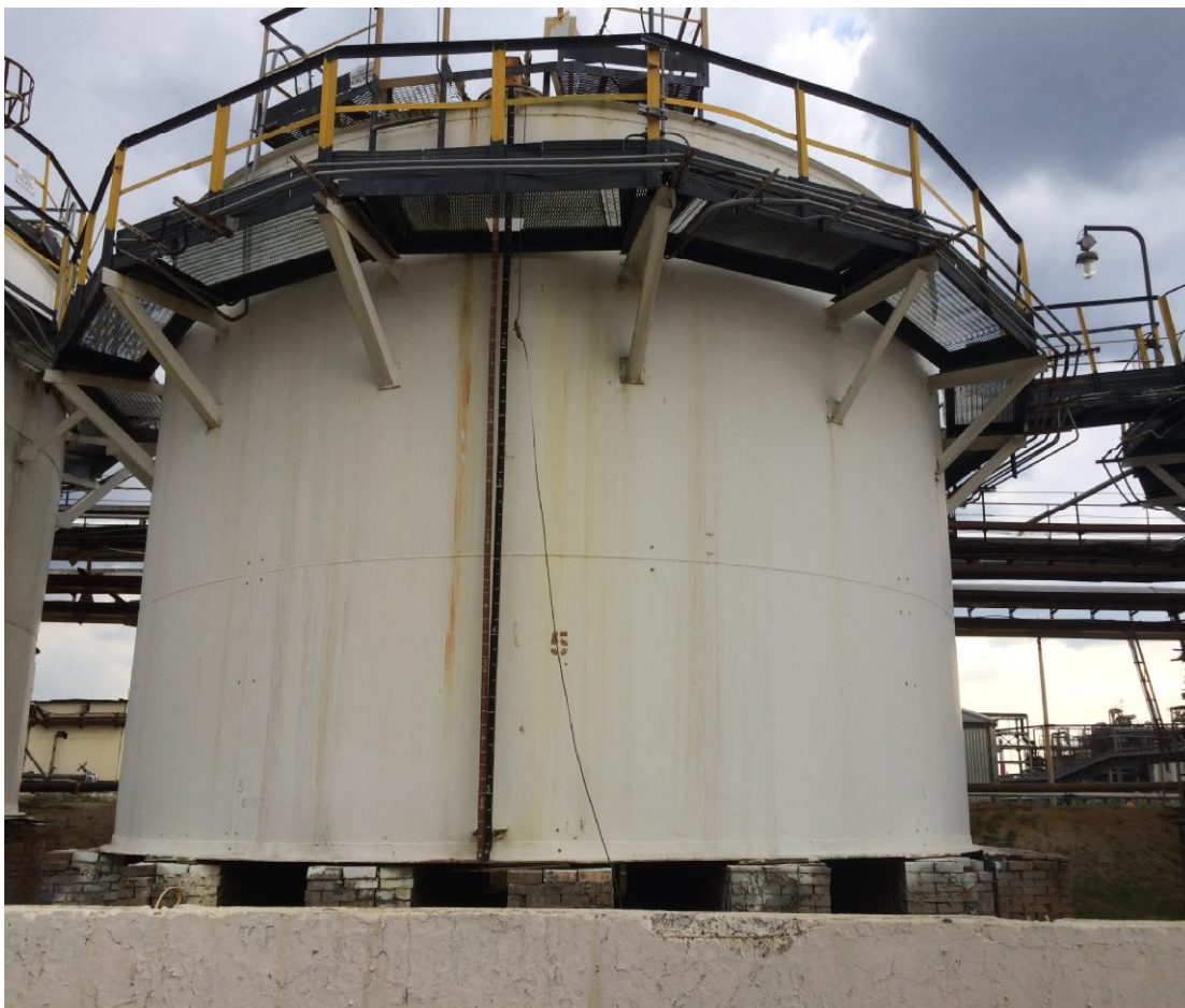
Рисунок 1 - Общий вид резервуара стального вертикального цилиндрического РВС-300
