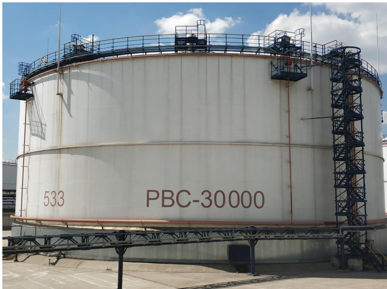
Рисунок 1 - Общий вид резервуара РВС-30000
