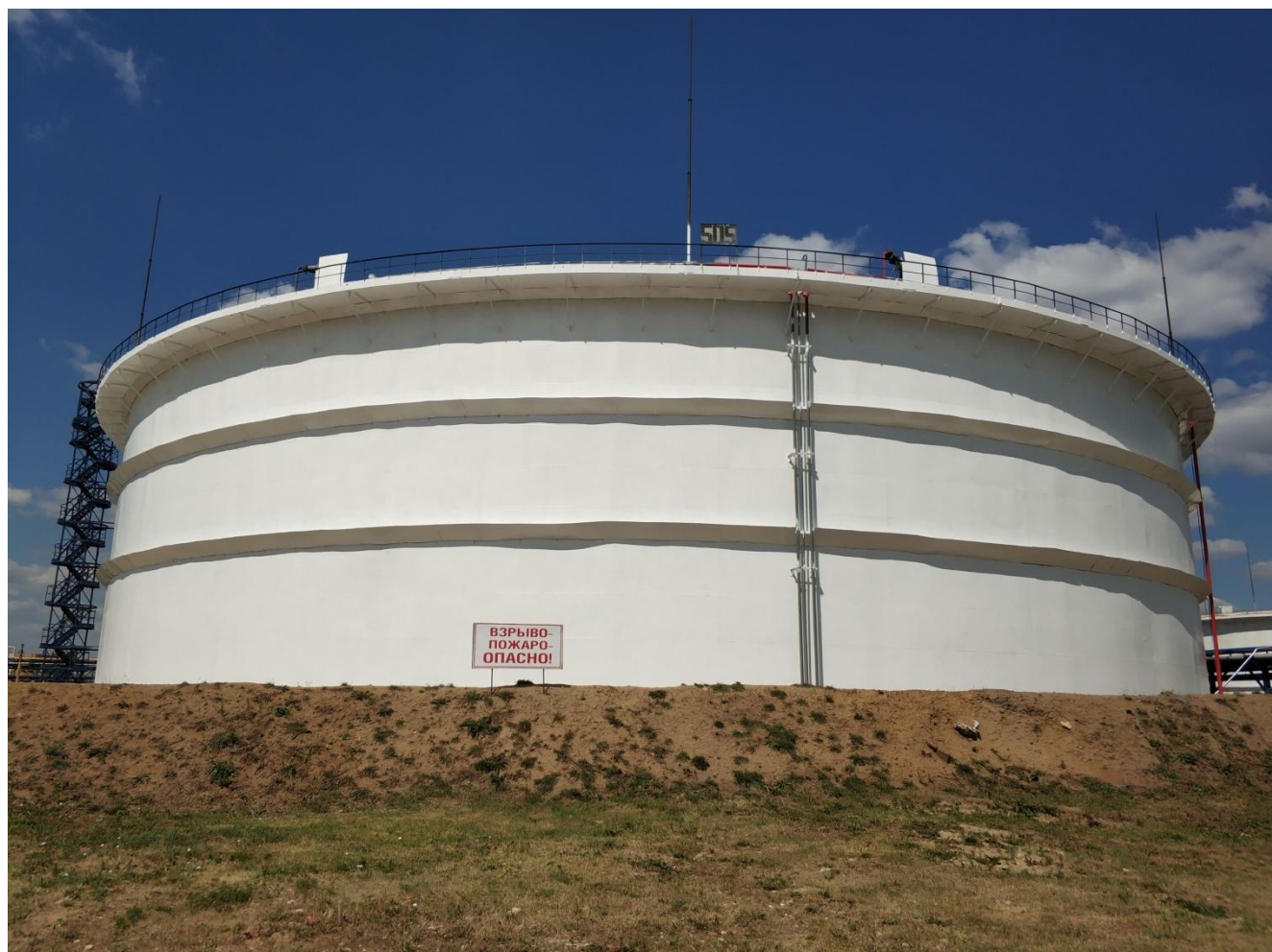
Рисунок 1 - Общий вид резервуара РВСПК-50000
