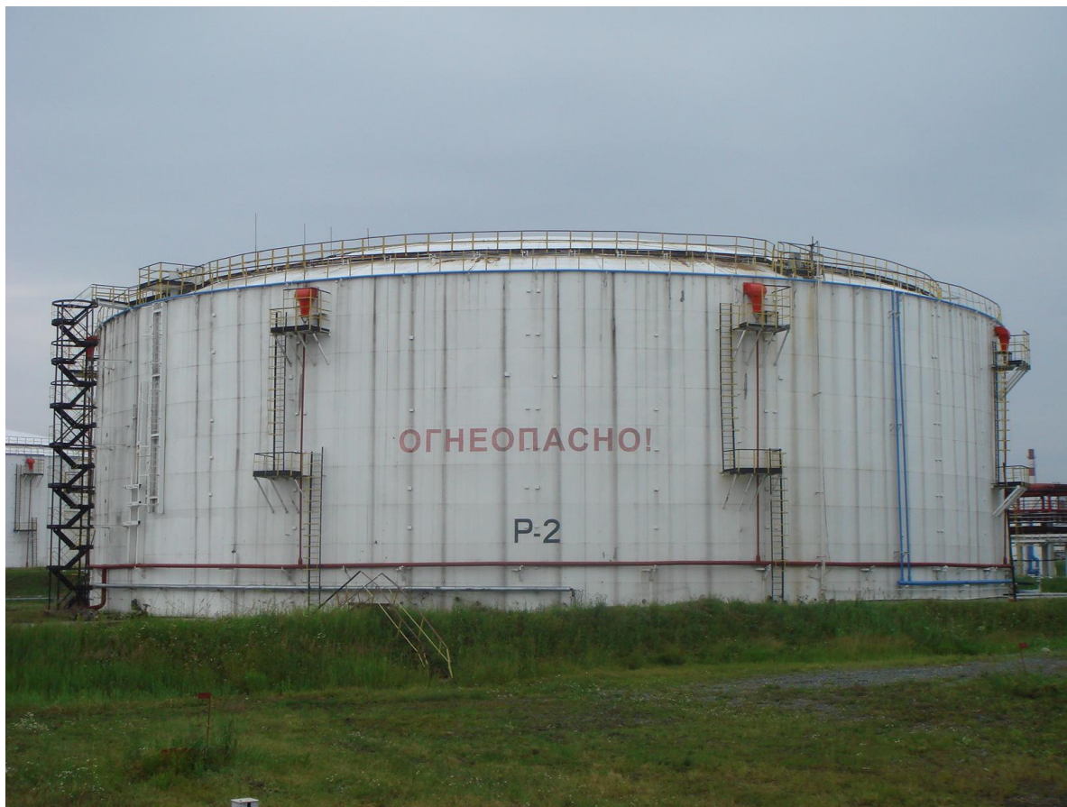
Рисунок 1 - Общий вид резервуара стального вертикального цилиндрического РВС-50000
