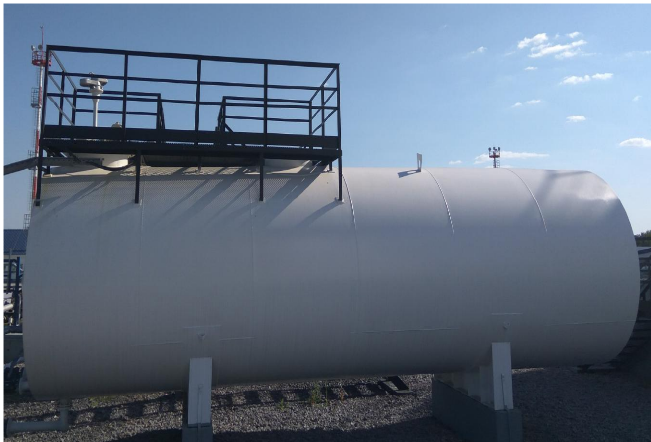
Рисунок 1 - Общий вид резервуара стального горизонтального цилиндрического РГС-50
