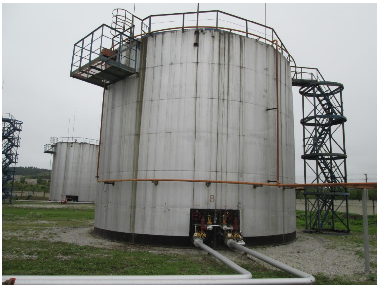
Рисунок 1 - Общий вид резервуара вертикального стального цилиндрического РВС-700
