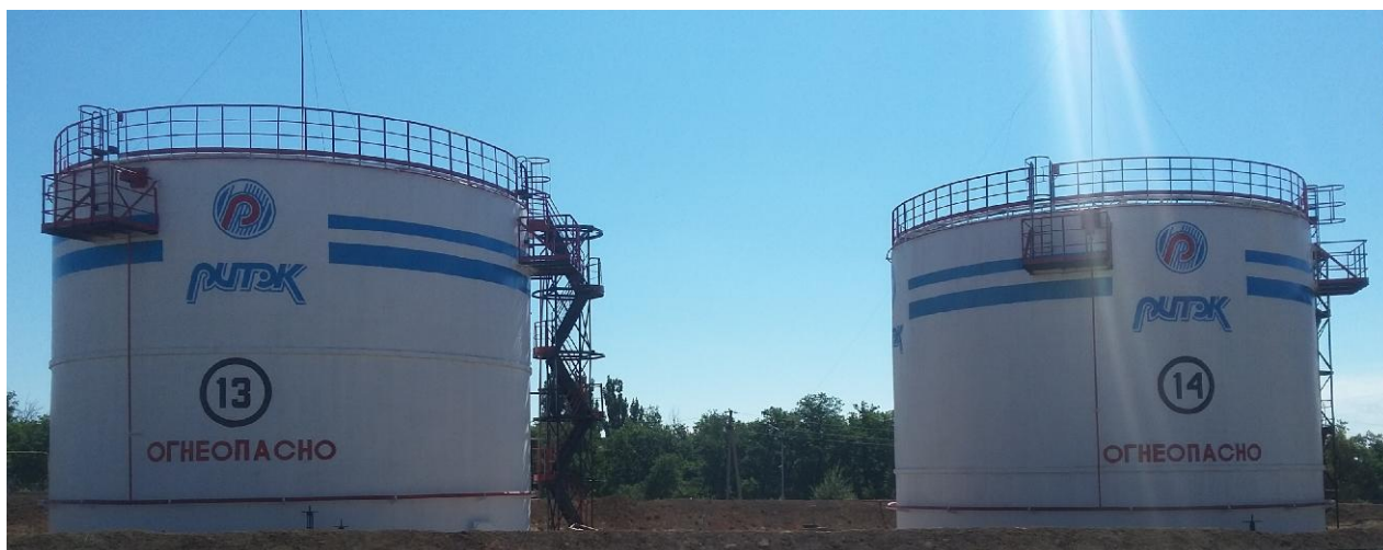
Рисунок 1 - Общий вид резервуаров вертикальных стальных цилиндрических РВС-2000.
