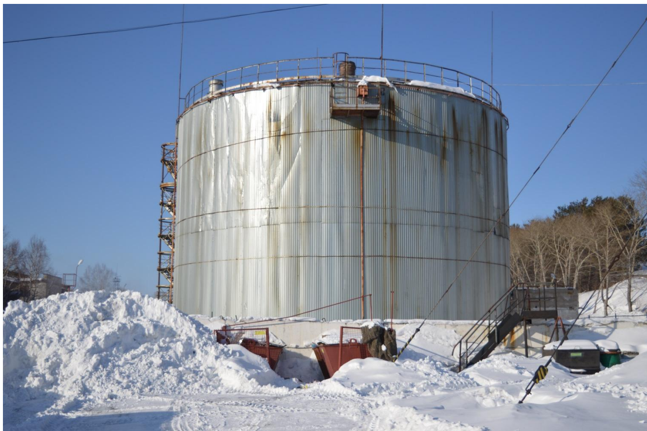
Рисунок 2 - Общий вид резервуара РВС-5000
