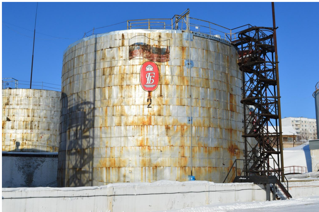
Рисунок 1 - Общий вид резервуара РВС-2000
