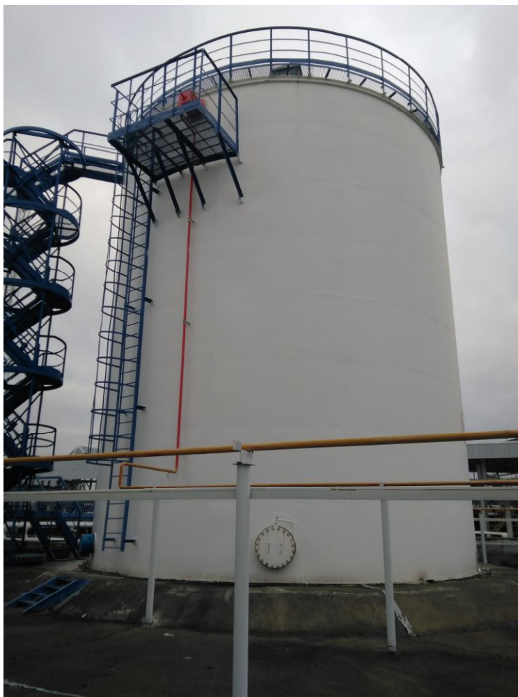
Рисунок 1 - Общий вид резервуара стального вертикального цилиндрического РВС-1000
