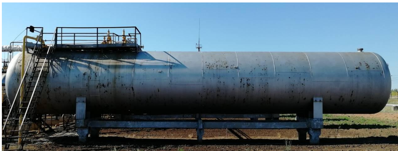
Рисунок 1 - Общий вид резервуара стального горизонтального цилиндрического РГС-200
