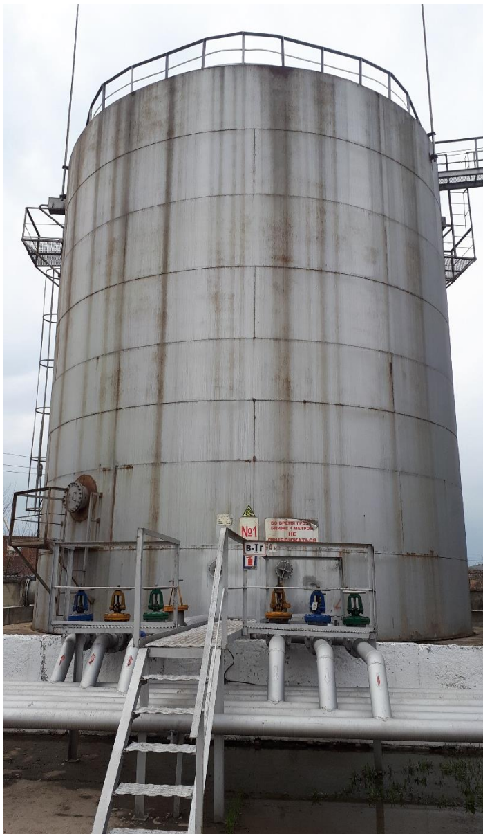
Рисунок 1- Фотография общего вида резервуара вертикального стального цилиндрического с понтоном РВСП-1000 заводской номер 1
