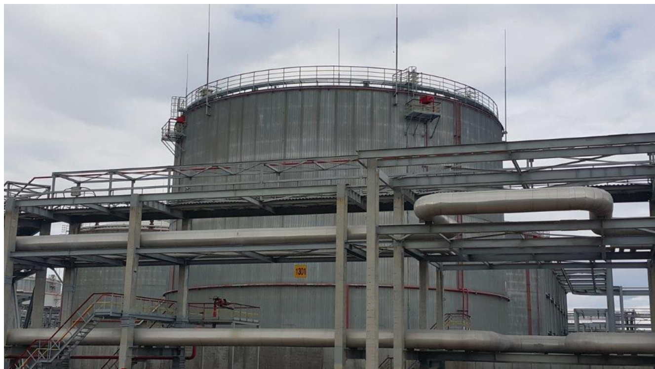
Рисунок 2 - Общий вид резервуара РВСт-20000
