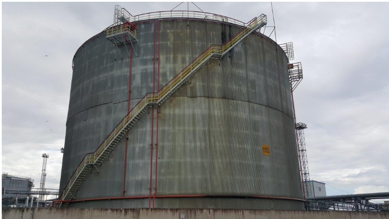
Рисунок 1 - Общий вид резервуара РВСт-15000
